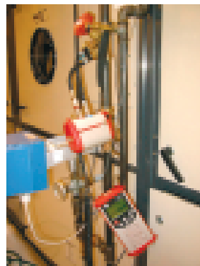
Figur 9.4. Måling af flow via strengreguleringsventil
