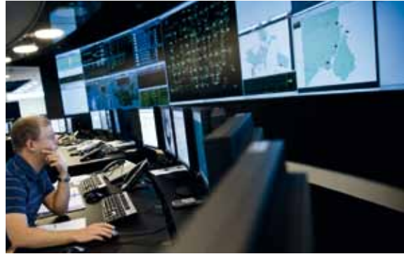
Kontrolrummet hos Energinet.dk
