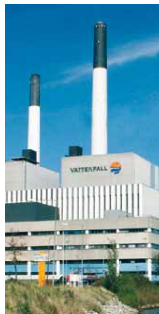
Amagerværket – kraftvarme med bl.a. halm. – Foto: Vattenfall
